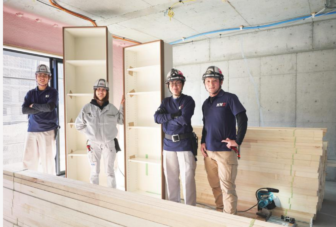
名古屋市内に建築中の4棟・350戸の大規模マンション建設現場にて、家具組立てを担当するMMSスタッフ。 左から金山SCの高橋優樹と安藤梨紗、名駅SCの三輪ちひろと田中達也職員。
